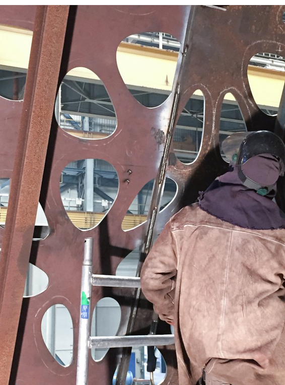
Het gatenpatroon van de zijwanden werd over honderden meters plaat uitgesneden
