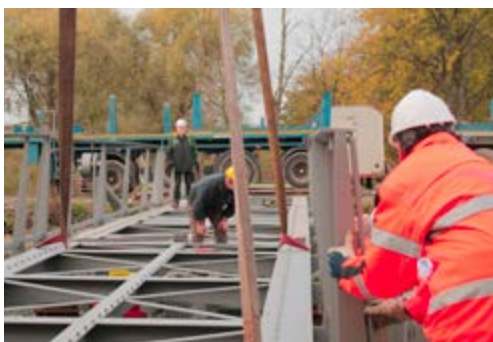
ZENNEGAT PONT MOBILE
