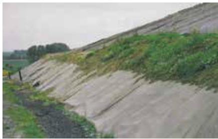
couche de couverture instable
